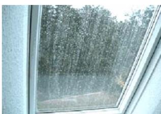
Aber ist solche Tauwasserbildung ein Produktmangel? Ganz im Gegenteil: Bei älteren Isoliergläsern kann der Effekt nicht auftreten, weil sie eine schlechtere Wärmedämmung haben.
