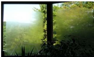
Scheiben können nur beschlagen, wenn sie kälter sind als die Luft um sie herum und wenn diese Luft viel Feuchtigkeit enthält. Denn Luft kann nur eine bestimmte Menge an Wasserdampf aufnehmen – und zwar umso mehr, je wärmer sie ist.
